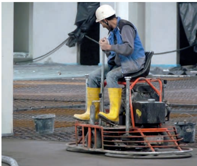
Abb. 1: Glättarbeiten in einer Halle
